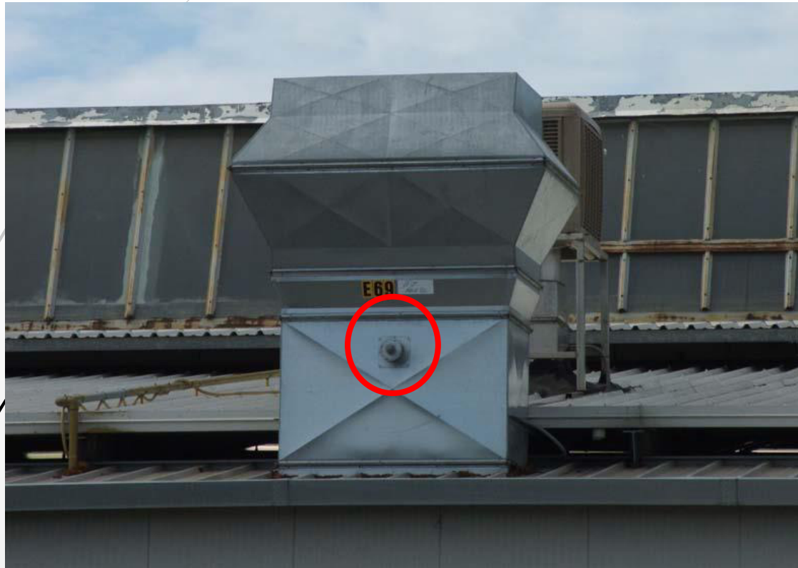
tratto rettilineo a valle del bocchello di campionamento troppo breve
