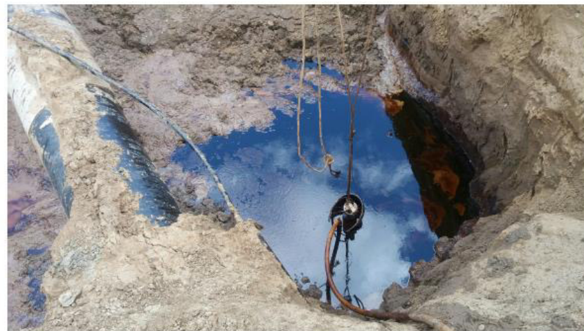
Foto 1. Chiazza di greggio sotto la condotta.
